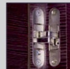
Zapuštěný pant pro dveře bezfaltové
